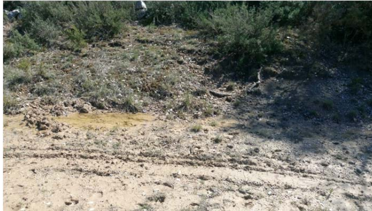
Figure 11 : Résurgence en pied de talus
