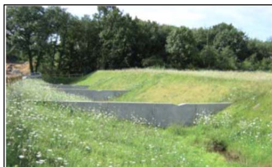
Figure 17: Exemple de noue de rétention
