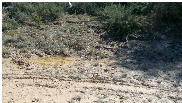
Figure 7 : Résurgence en pied de talus
